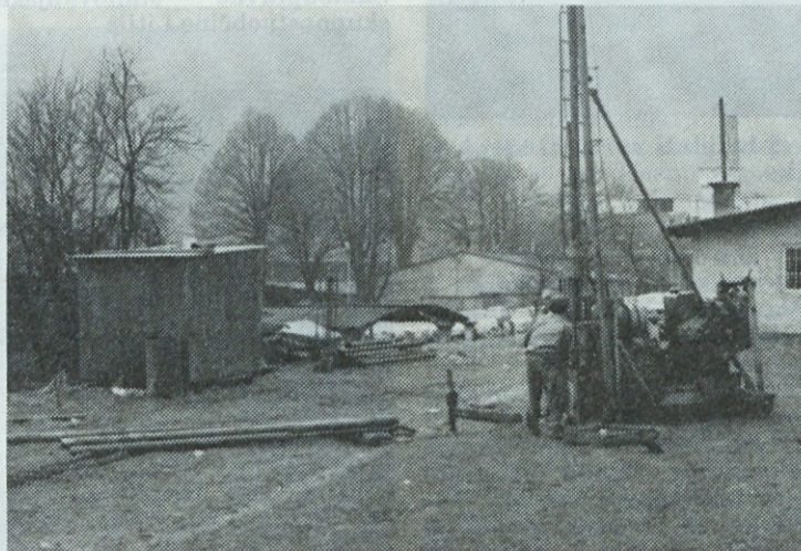
Delavci zavoda za raziskavo materiala iz Ljubljane, s strojno napravo odvzemajo vzorce tal, da bo lahko projektant v gradbenem načrtu, upošteval nosilnost tal, določil konstrukcijo skladišča in temeljne zgradbe.
