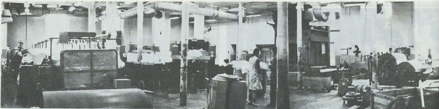
Po zgraditvi mešalnice vlaken smo prešli v drugo fazo izvajanja srednjeročnega plana: rekonstrukcijo čistilnice in predpredilnice.
