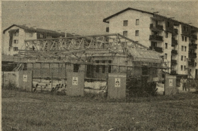
Izgradnja nove telefonske centrale v Žalcu že nekaj časa ne napreduje. Vsem tistim, ki nestrno pričakujejo nove priključke, pojasnilo, da se je zataknilo pri dobavi strešne kritine. Sedaj so tudi ta problem rešili in upamo, da bo objekt pravočasno gotov.
