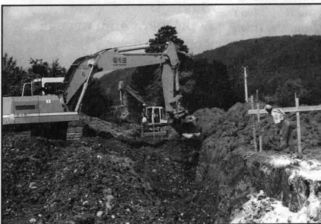
Gradnja povezovalnega kanala med Rečico in Prihovo (foto: Ciril Sem)
