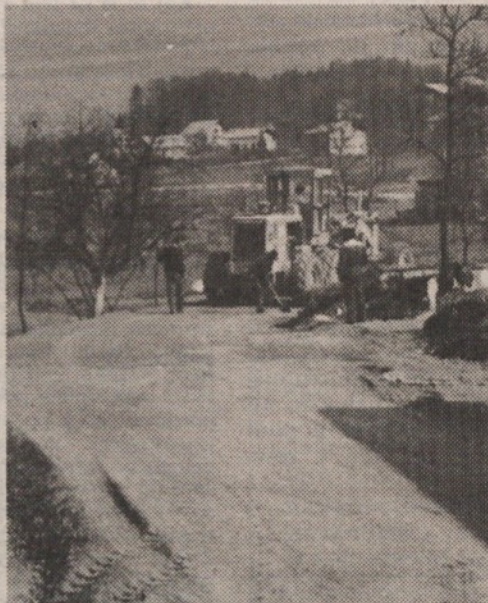
Zadnja dela pred asfaltiranjem ceste Studenec—Škocjan.
