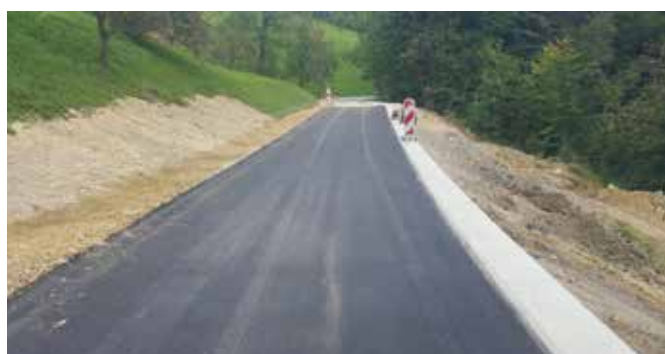
Plaz na cesti Vodruž-Kozarica-Slemene - po sanaciji
