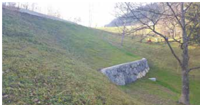
Plaz na cesti Javornik-Svetli dol-Kanjuce - »Pri Jelenc« po sanaciji
