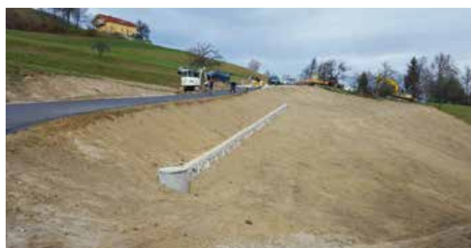
Plaz na cesti Javornik-Svetli Dol-Kanjuce »Križišče« - po sanaciji
