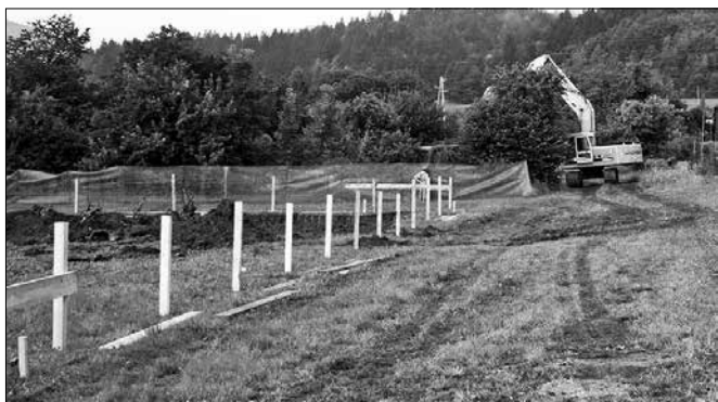
Podjetje Remont d.d. Celje je 21. junija pričelo z izkopi za gradnjo varstveno delovnega centra in bivalne enote v Mozirju.
