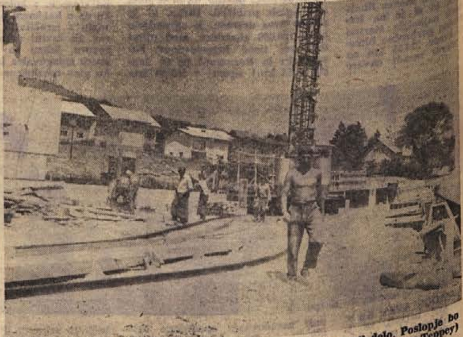
Na gradbišču osnovne šole v Krškem je Pionir dobro zastavil delo. Poslopje bo do zime pod streho, vseljivo pa prihodnje leto. (Foto: Jožica Tepper)
