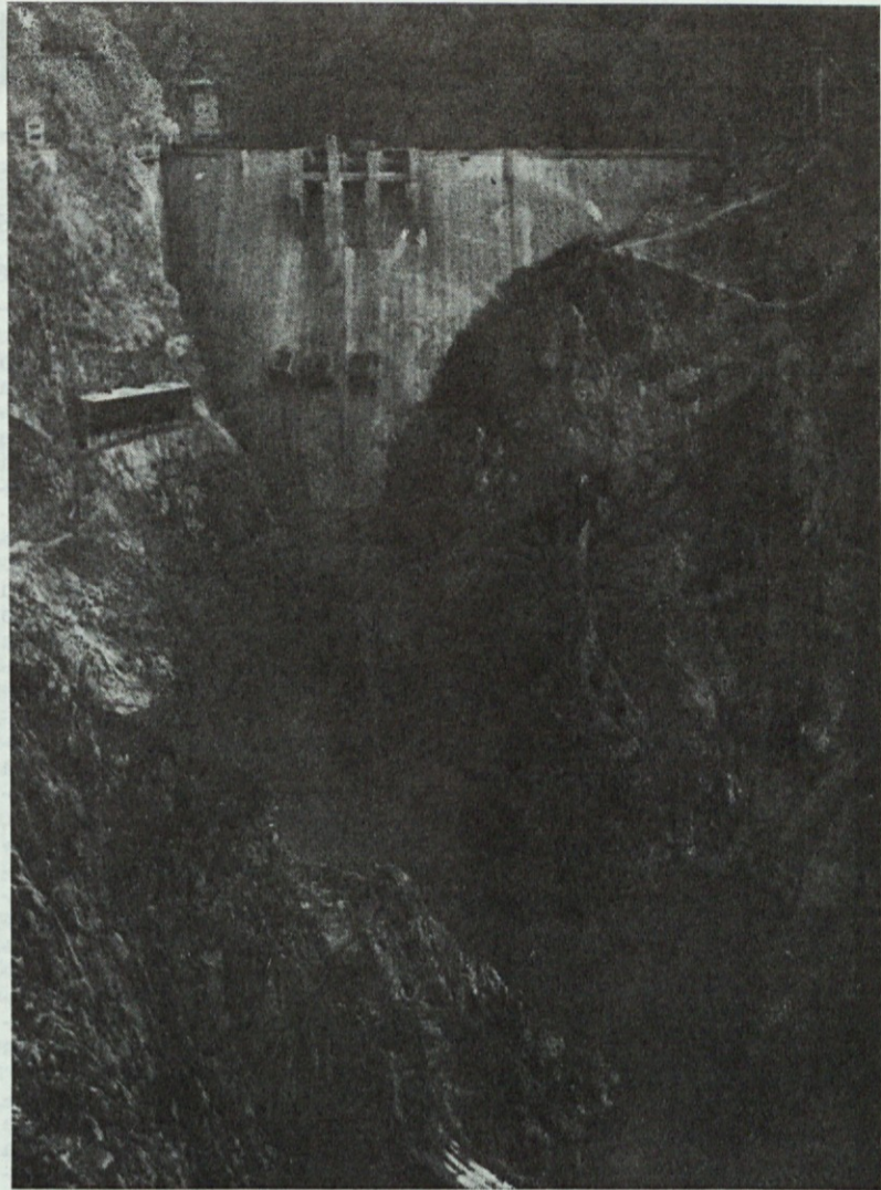
Jez za He-Martinje v znamenitem kanjonu reke Pive. Jez je visok več kot 200 m in predstavlja velik dosežek tudi v gradbeništvu — Foto: Vidrih
