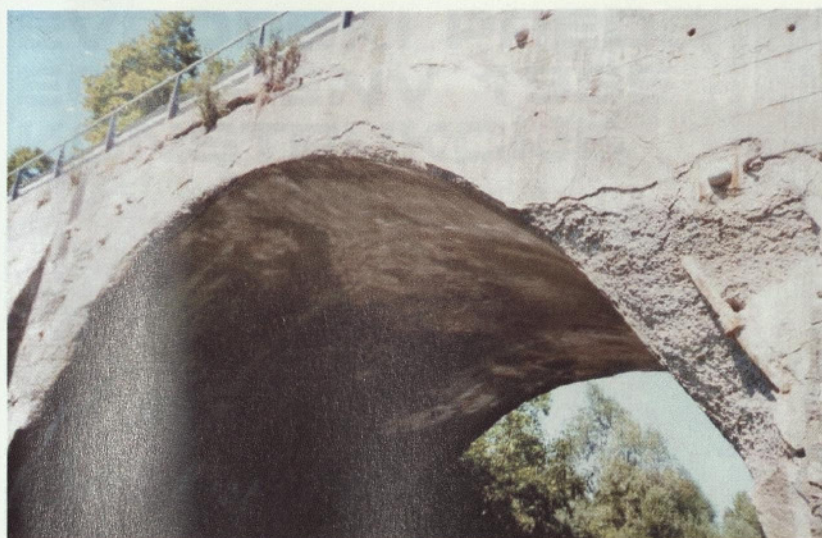
Slika 14: Injektiran most čez Pivko
