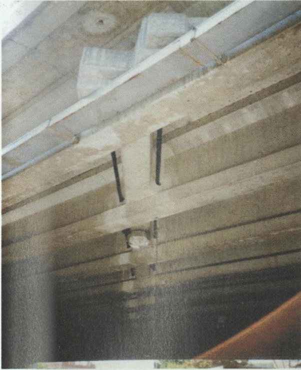
Slika 8: S kabli ojačen poševni prečnik
