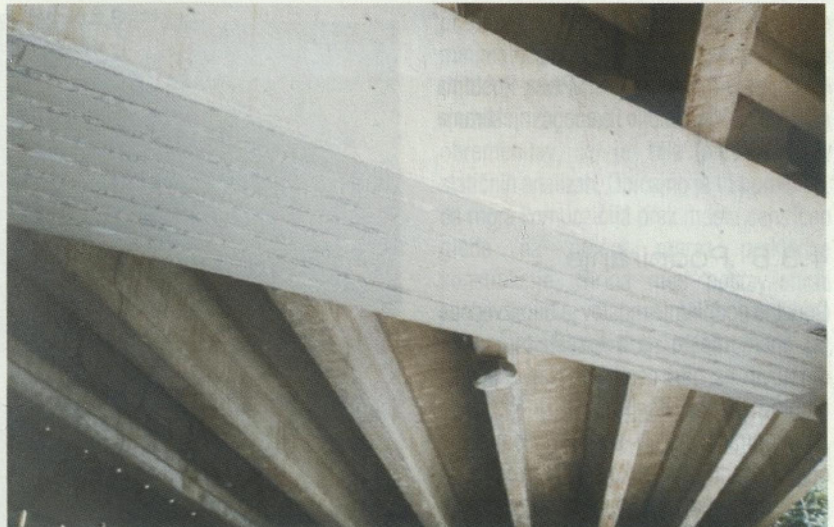
Slika 10: Ojačitev grede med stebroma
