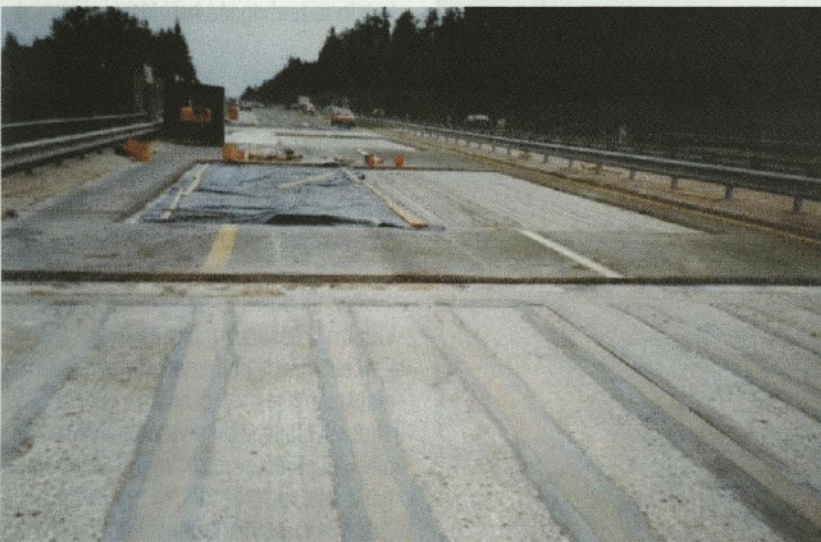
Slika 7: Vzdolžna ojačitev plošče zgoraj
