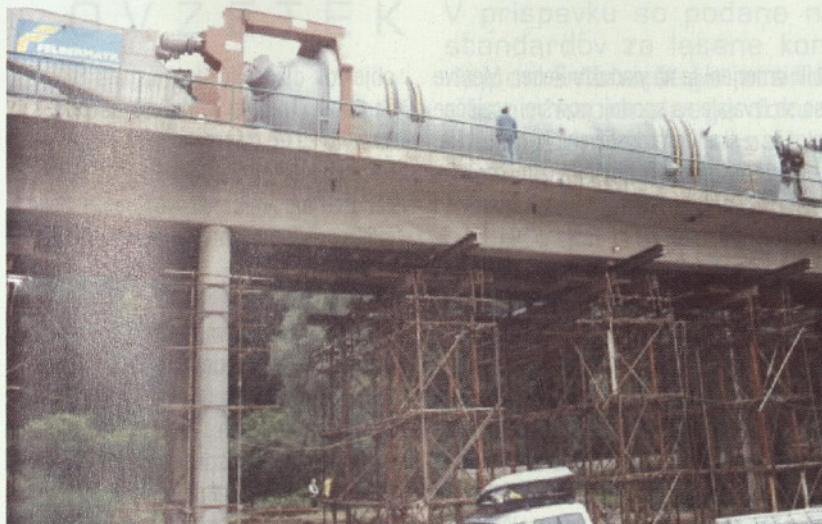
Slika 15: Podpiranje viadukta Ponikve
