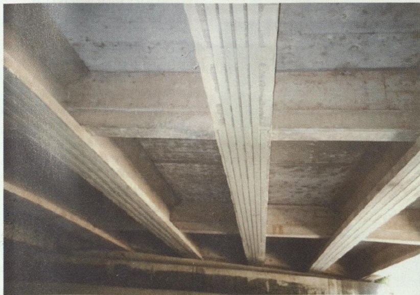
Slika 4: Ojačitev srednjih treh nosilcev
