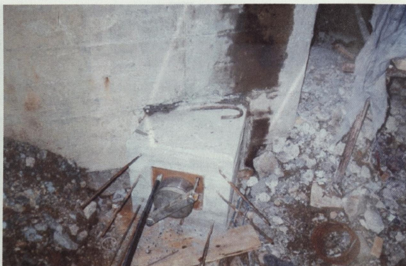
Slika 11: Dodatno prednapenjanje ležiščne grede
