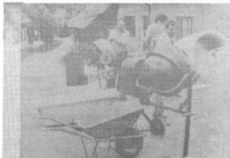
Složnost se živi na vasi. Takole so Dreničani strnili skupaj svoje moči pri gradnji betonske gnojščne ograde.
