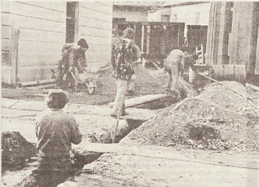
Še zadnja dela na zunanjih priključkih pri garažah za UJV Celje
