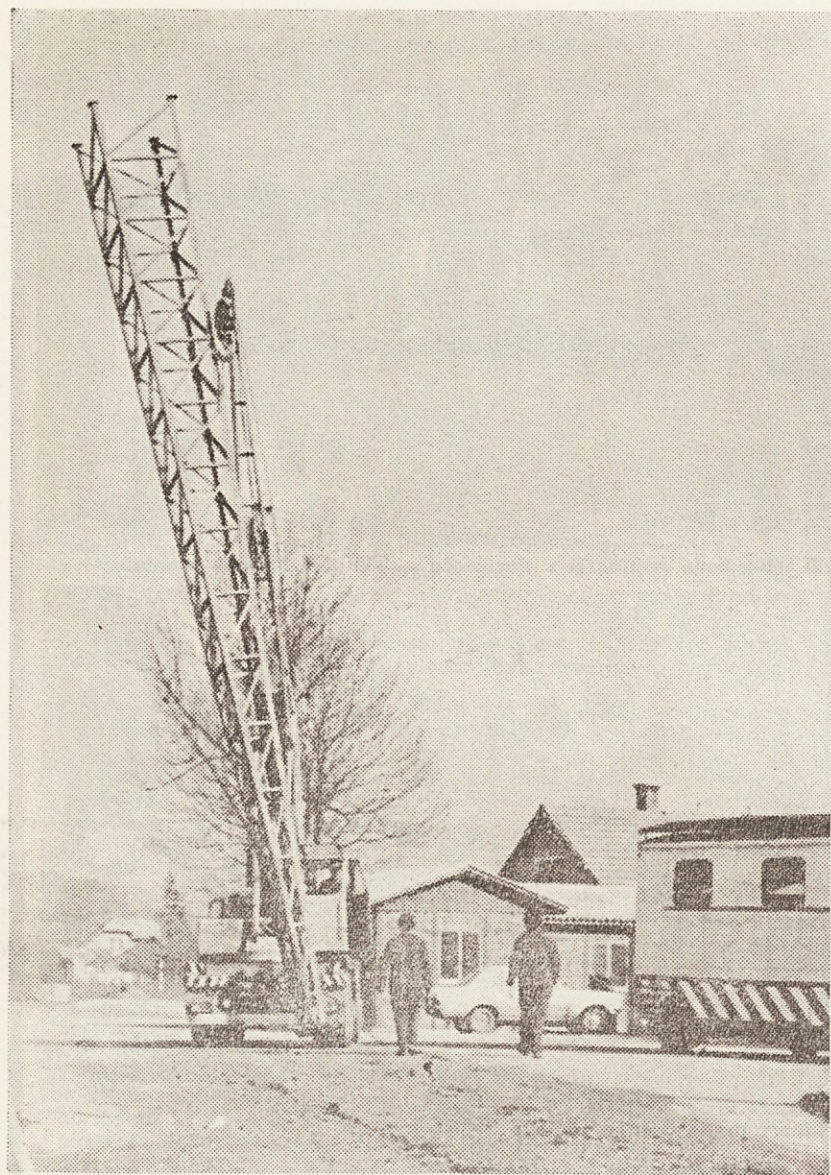
Montaža jeklene konstrukcije
