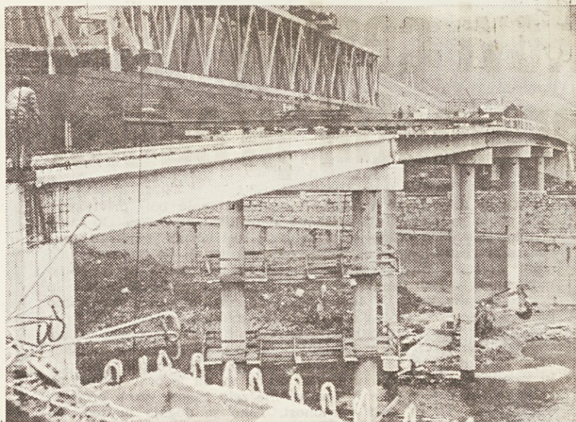
Montaža se opravlja že v zadnjem polju
