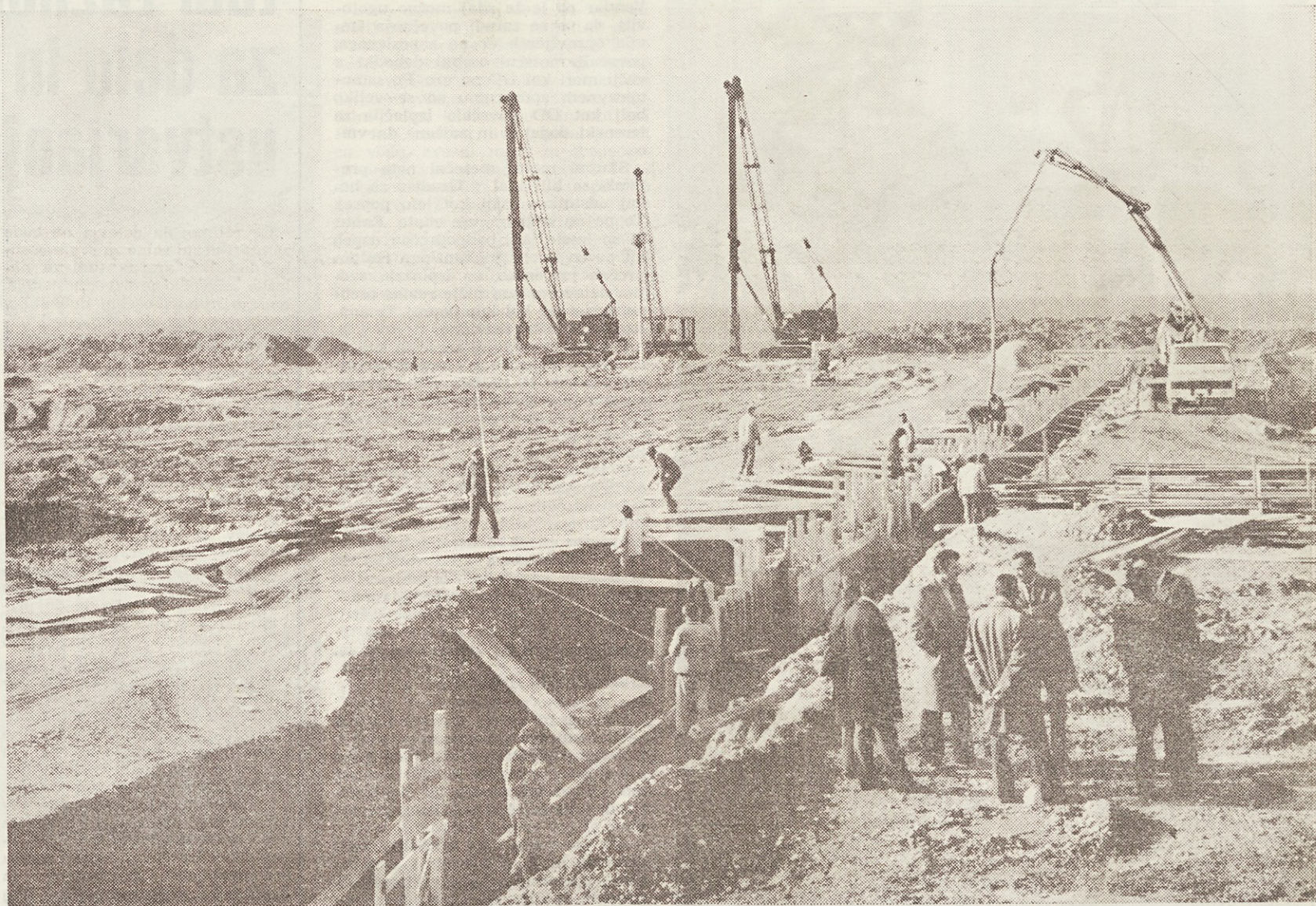
Zaščitni zid za prvo jedrsko elektrarno bo segal v globino od 10 do 17 m
