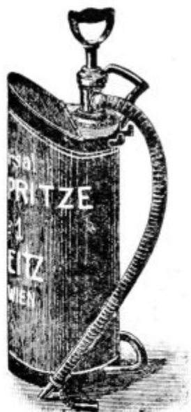
Podoba 8. Brizgalna za pomivanje cedilnih sitin sodov s opodo. (Tvrdka Seitz).
