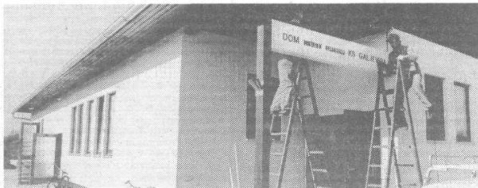
Prej je bila kot vsaka druga montažna hiša, zdaj, z napisom, pa je postala tudi uradno dom krajanov KS Galjevica. In to je res njihov dom, saj so ga zgradili z lastnim delom in le z nekaj pomoči iz občinskega žaklja.
