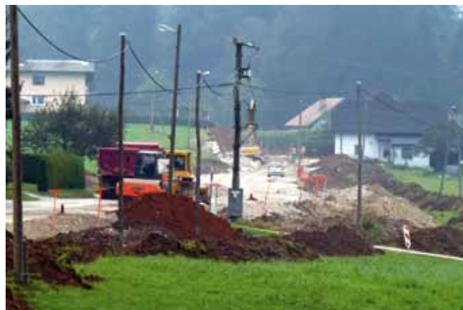
Tudi svetniki LNK smo zaslužni, da se ob koncu mandata izvaja celovita rekonstrukcija lokalne ceste Habe-Martink. Zaradi našega vztrajanja in strokovnih utemeljitev je bil ta projekt uvrščen v letošnji proračun.
