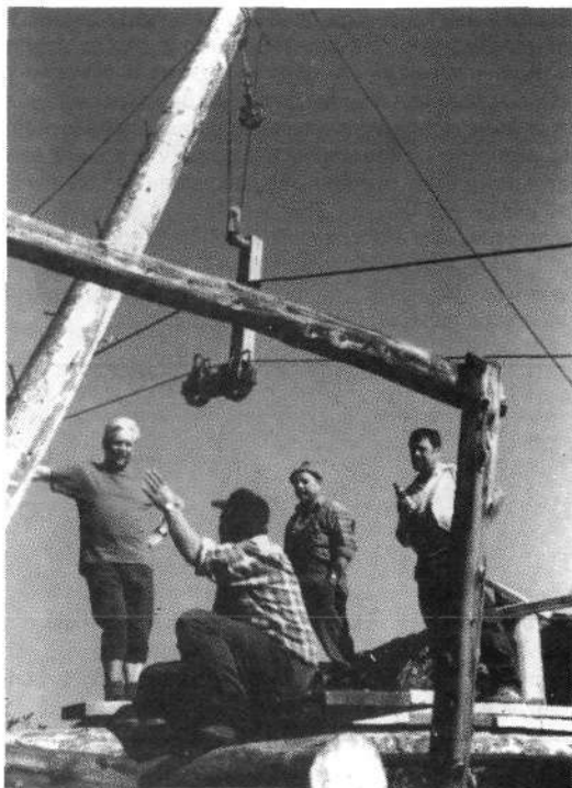
Obnavljanje planinske tovorne žičnice na Kališče: veliko delo, ki ga morajo lastniki žičnice opraviti čisto sami
