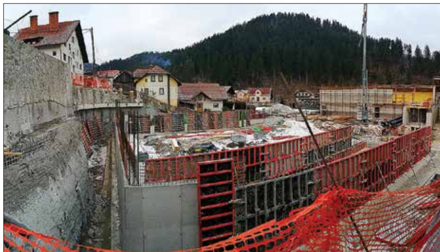
Zaradi ugodnih vremenskih razmer gradnja centra vidno napreduje. (Fotodokumentacija Občine Luče)
