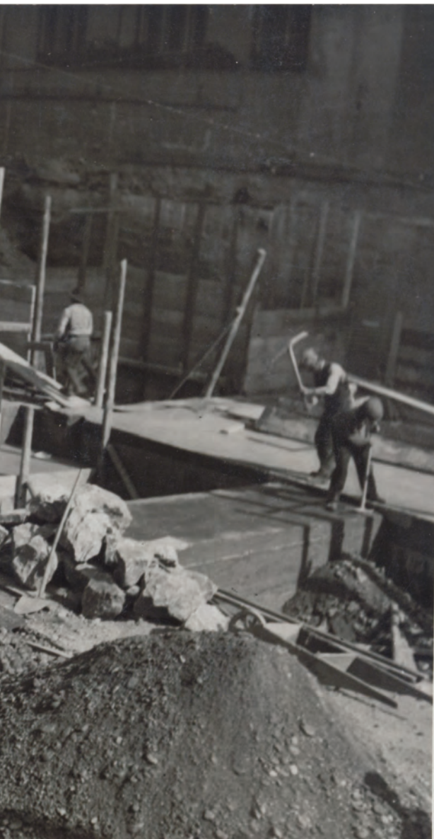
Začetek izkopa temeljev za Nebotičnik v Ljubljani.
