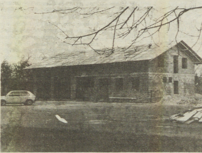
Pri gradnji gasilskega doma v Veliki Polani so se izkazali tudi zasebniki: Tompa, Kranjec, Hozjan, pa tudi Cvetko, ki je brezplačno uredil ostrešje.
