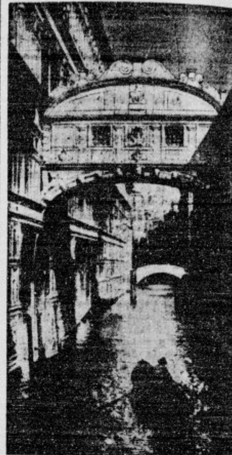
V Benetkah so okradli takozvani »Most vadinov«. Nihče ne ve, kdaj so odnesli s mosta dragoceno in težko svinčeno streho
