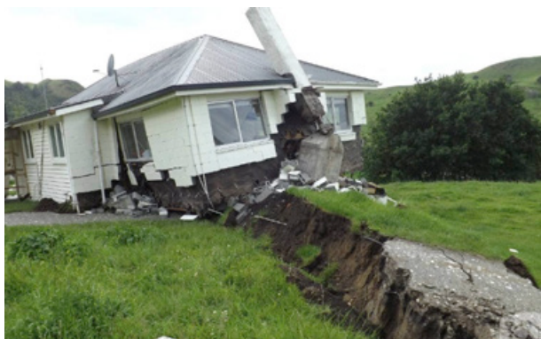
Slika 8: V izjemnih primerih lahko ustrezno zgrajena hiša zdrži celo prelomni pretrg, ki se zgodi pod njo. Potres Kaikoura leta 2016 na Novi Zelandiji (vir: www.stuff.co.nz/science )
