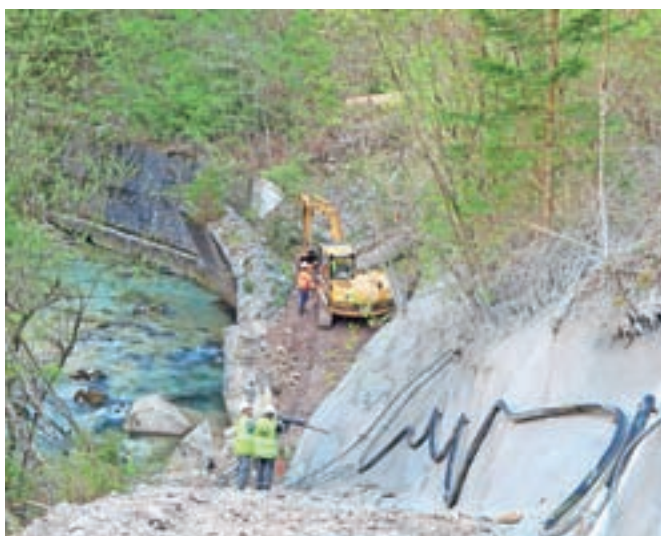
Sanacija podpornega zidu pod cesto v Kamniško Bistrico je v polnem teku. / FOTO: JASNA PALADIN
