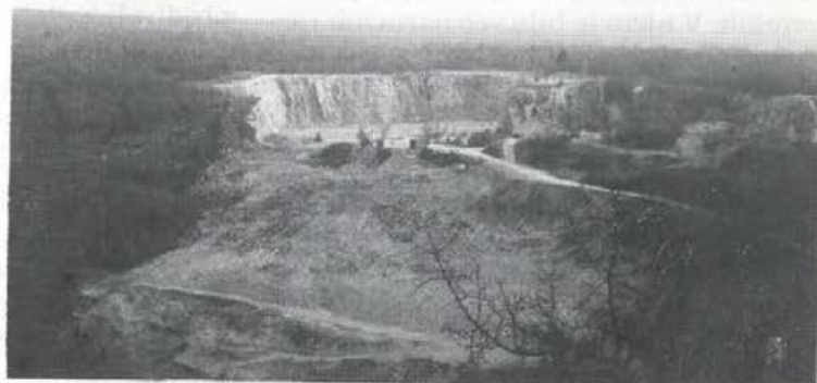
Devetaki: pogled s pobočja Brestovca na največji doljanski kamnolom
