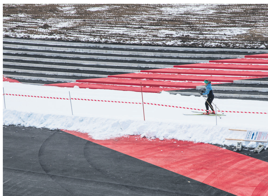
Pogled na tekaško progo s strehe prireditvenega odra, ki je urejena kot razgledna ploščad. (Foto: Marjan Klepec)
