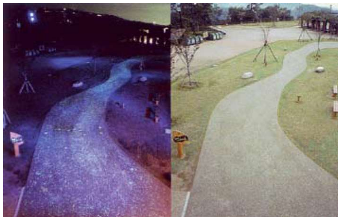
Slika 7: Pot za pešce z dodanimi fosforescentnimi steklenimi delci in z drugimi luminiscentnimi sestavinami [Ritter, 2007: 121].
