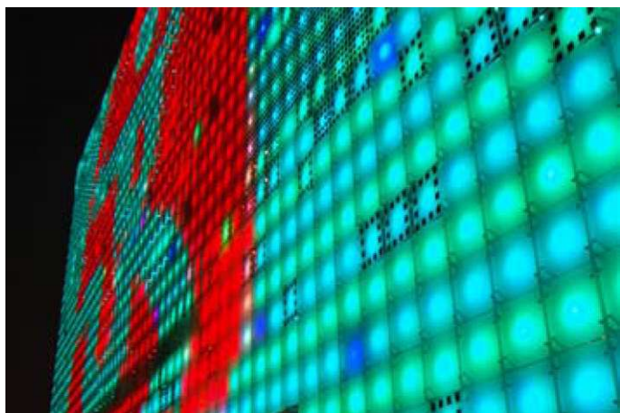
Slika 9: Medijska fasada - sončne celice podnevi pretvarjajo energijo iz sončne v električno, ki jo ponoči s pomočjo LED zaslon uporablja za osvetlitev [http://www.greenpix.org/ <9.3.2009>].
