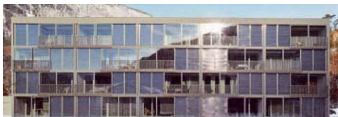
Slika 2: Gradivo s fazno preobrazbo je vgrajeno v zasteklitev fasade in pripomore k boljši energijski učinkovitosti stavbe in videzu fasade, ki glede na fazno stanje gradiva spreminja stopnjo prosojnosti [Ritter, 2007: 171].
