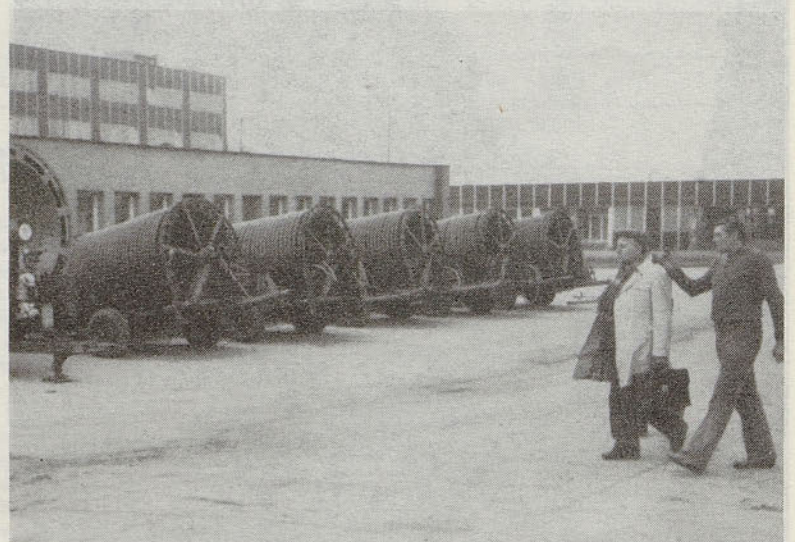
Namakalniki na hmeljskem inštitutu pripravljeni za novo sezono v Žatcu.
