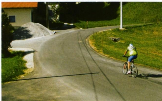
Gladko po prenovljeni cesti proti Veharšem.
