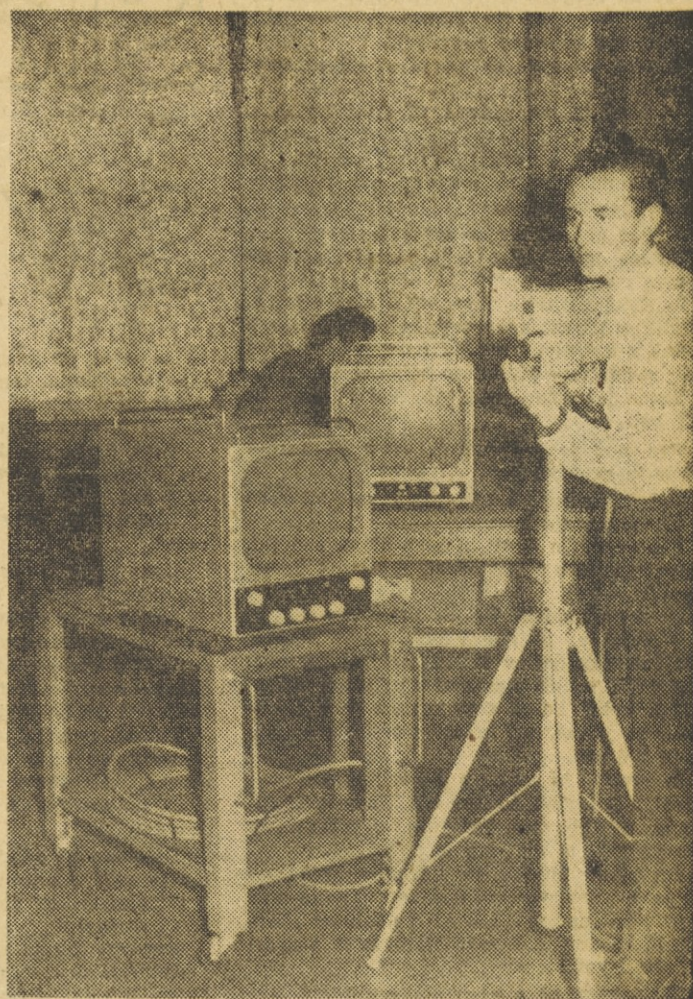
NA NAJBOLJ ŽIVLJENJSKO NEVARNIH DELOVNIH MESTIH BO BUDNO ČLOVEKOV OKO ZAMENJALA TELEVIZIJSKA KAMERA. — NA SLIKI VIDIMO CELOTNO TELEVIZIJSKO APARATURO, KI SO JO IZDELALI V TELEVIZIJSKEM LABORATORIJU »INDUSTRIJE ZA ELEKTROVEZVE« V LJUBLJANI.
