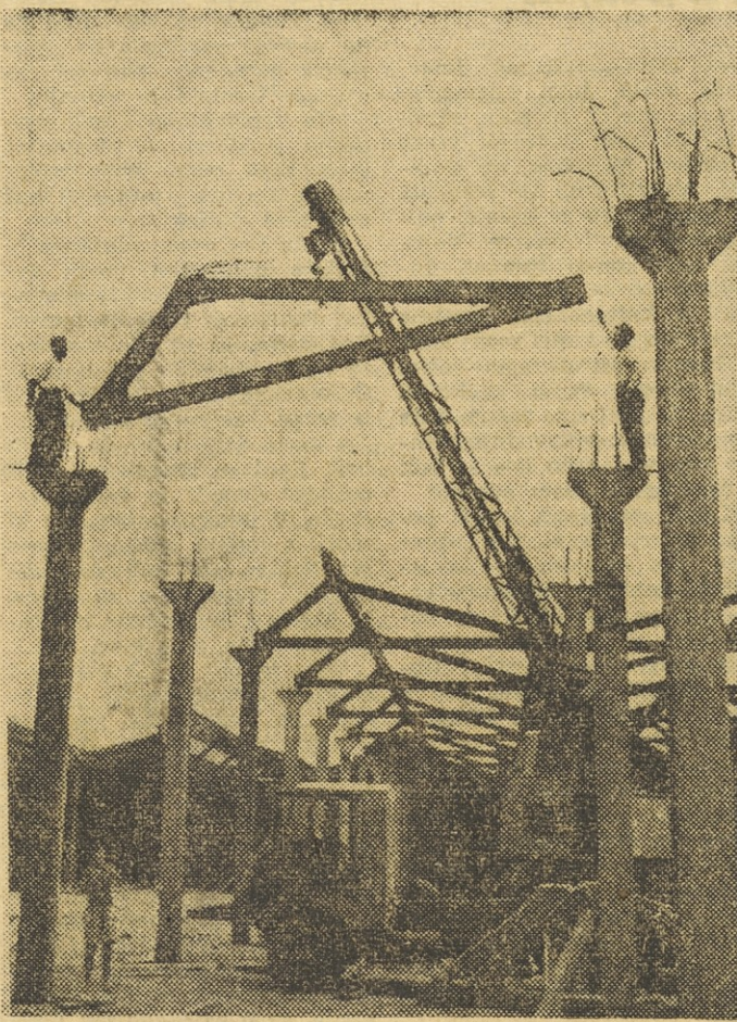
Takole so gradbeni delavci gradili del poslopja nove tovarne porcelana v Titovem Velesu
