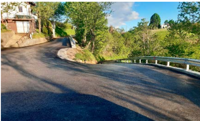
Obnovljen cestni odsek. Foto: Andrej Milošič
