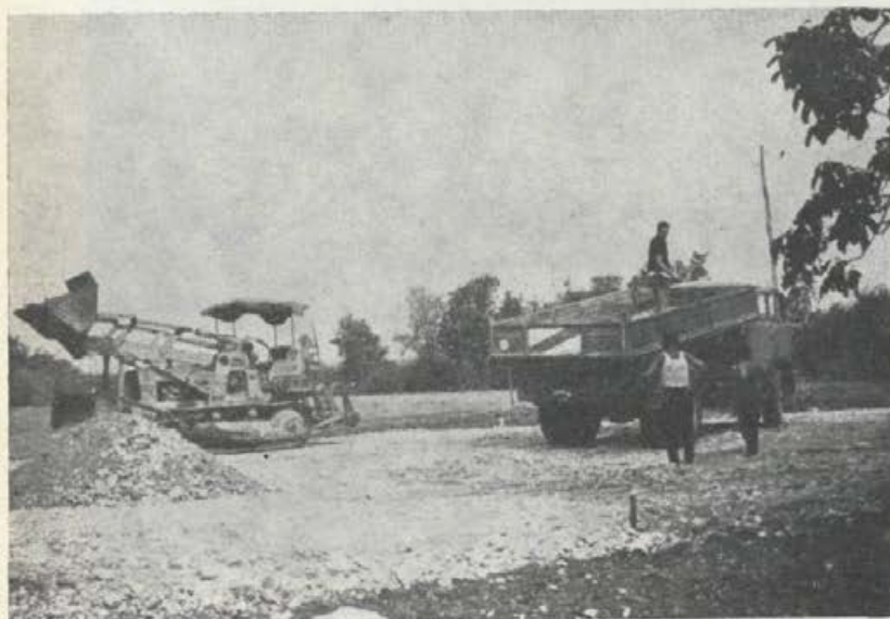
Pri delu novega igrišča v Doberdolu
