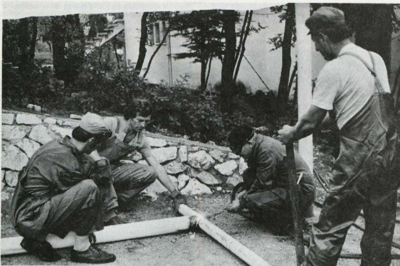
Delovni utripi iz Crikvenice - Preurejevanje strešne konstrukcije nad parkirnim prostorom
