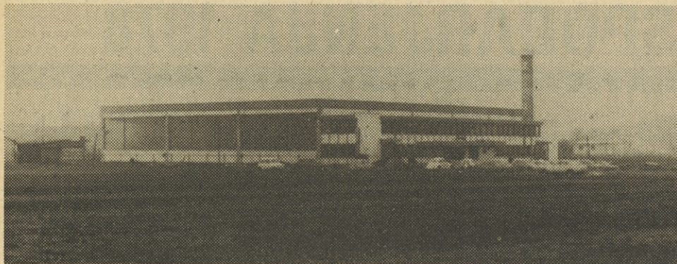
Novogradnja TOZD Blisk v Murski Soboti
