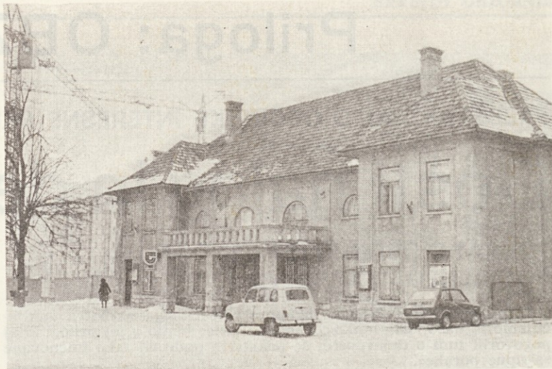
Kulturni dom v Cerknici je potreben obnove
