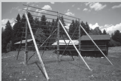
□ Slika 6. Fotografija chischnerja v dve okni z močnimi zavetrovalnimi tramovi dokazuje začasnost naprave, ki sama ne bi mogla stati (Obersaxen, Meierhof/Graubunden 2004).
