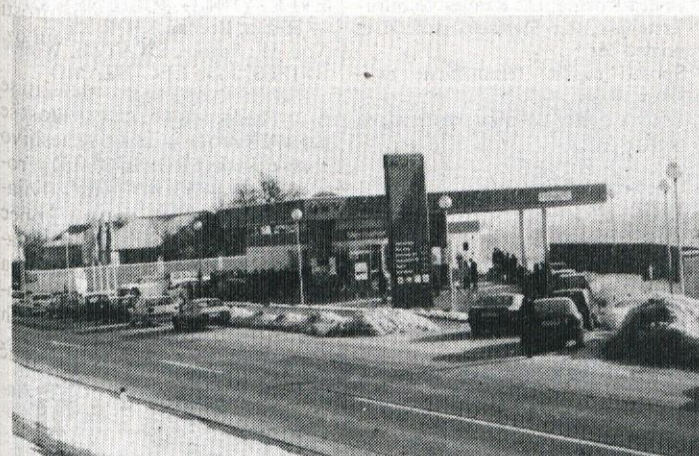
Pogled na nov bencinski servis na Brezovici
