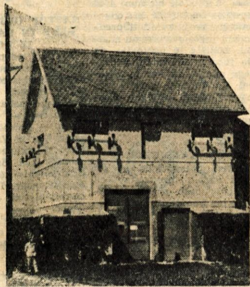
Nešteto odvodov se križa v majhni razklopnici postaji na Polici
