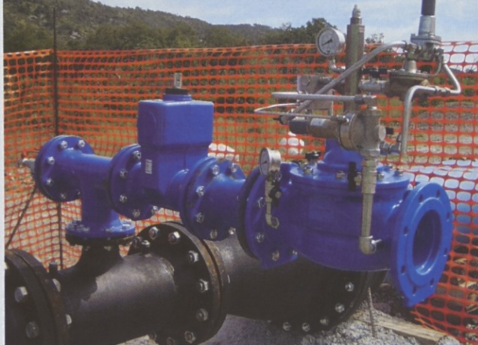
Zgornji del črpalke poskusne vrtine Klariči med obratovanjem 2. septembra 2008.
