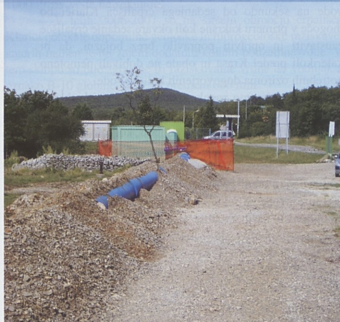
Začasni, 700 metrov dolg vodovod za odvajanje vode iz poskusnega črpališča v vrtačo na Ogradi, severozahodno od Vrha Gnojn (143 m), blizu meje med Slovenijo in Italijo.
