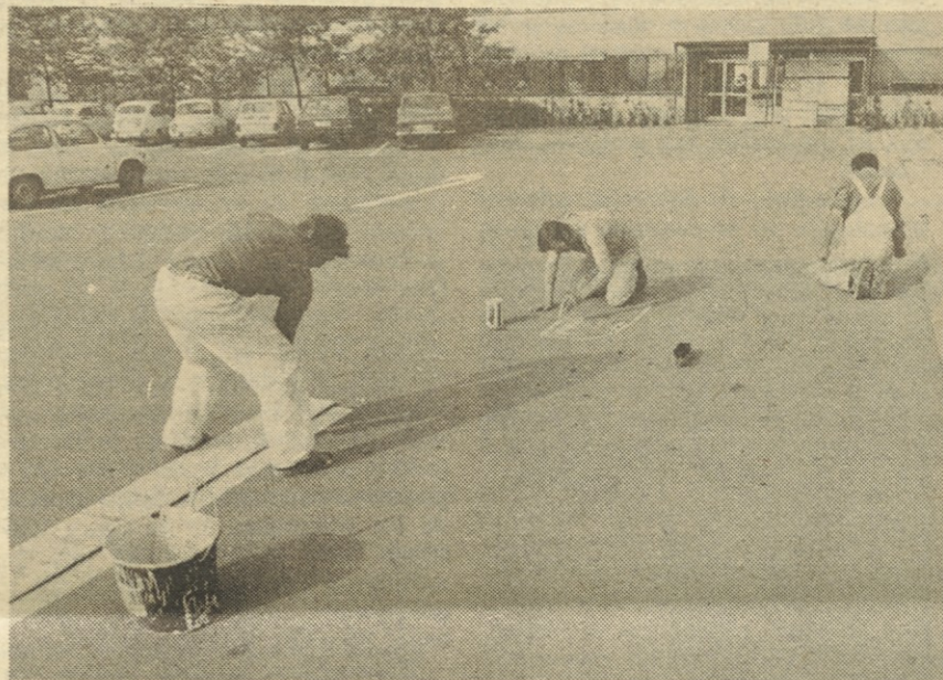
ISKRA INVEST SERVIS dobro skrbi za varnost prometa v Stegnah. Te dni obnavljajo in prilagajajo talne oznake na parkirnih prostorih pred vsemi tovarnami. Prav je tako, več reda bo in tudi bolj varno.
