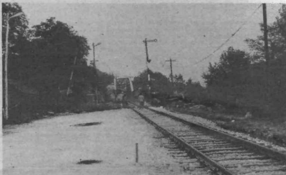
Čez dan ali dva bodo začeli z obnovo še precej dotrajanega črnuškega mostu čez Savo. Tovarnjski bodo do konca oktobra, ko bo obnova predvidoma končana, vozili skozi Tacev ali Šentjakob, osebni avtomobili pa bodo v eni smeri vozili preko starega črnuškega mostu, v drugi smeri pa si bodo delili »življenjski prostor« s »Kamničanom«, saj bo promet spajlan preko železniškega mostu (na sliki). Za začetek del je že vse nared, gneča na cesti pa bo zdaj prav gotovo še hujša, kot smo je vajeni ob prometnih konicah, zato se najbrž tudi voznikom osebnih avtomobilov spleta zapeljati do Šentjakoba ali Tacev.
