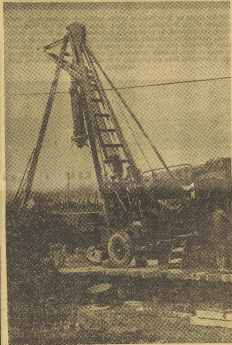
Do jeseni prihodnjega leta bo dokončan nov cestni most čez Mali graben na Viču, ki bo zamenjal starega, poznanegega pod imenom Dolgi most. Teren je treba prej še temeljito preiskati. Sondaže izvršuje »Elektrosonda« iz Zagreba. Kot pravijo, bodo nasipi, ki jih gradi podjetje Slovenija ceste, končani že to leto, vanje pa bodo vgradili 75.000 kubičnih metrov materiala. Z dograditvijo novega mostu bo odpadel dosednji nevarni prelaz preko železnice, kjer so bile doslej pogoste prometne nesreče
