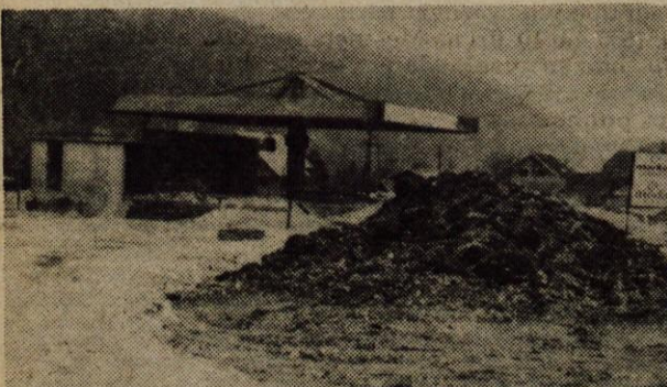
Kranjska gora - Delavci SGP Gradbinec grade med glavno cesto in Pišenco novo bencinsko črpalko Petrola. Novo črpalko bodo odprli v začetku letošnje poletne sezone. - Foto: B. B.
