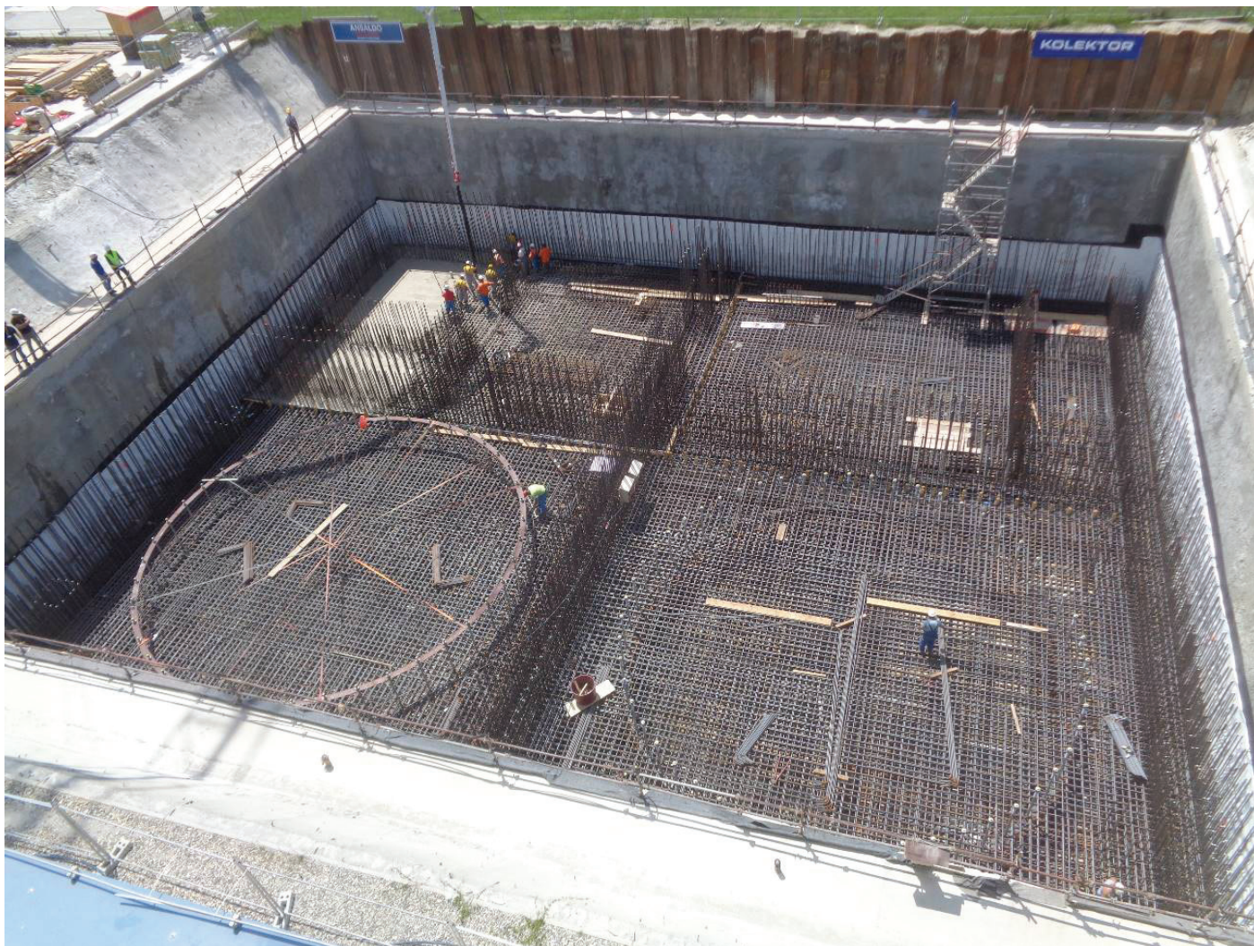
Slika 8 • Vgradnja betona v talno ploščo.
