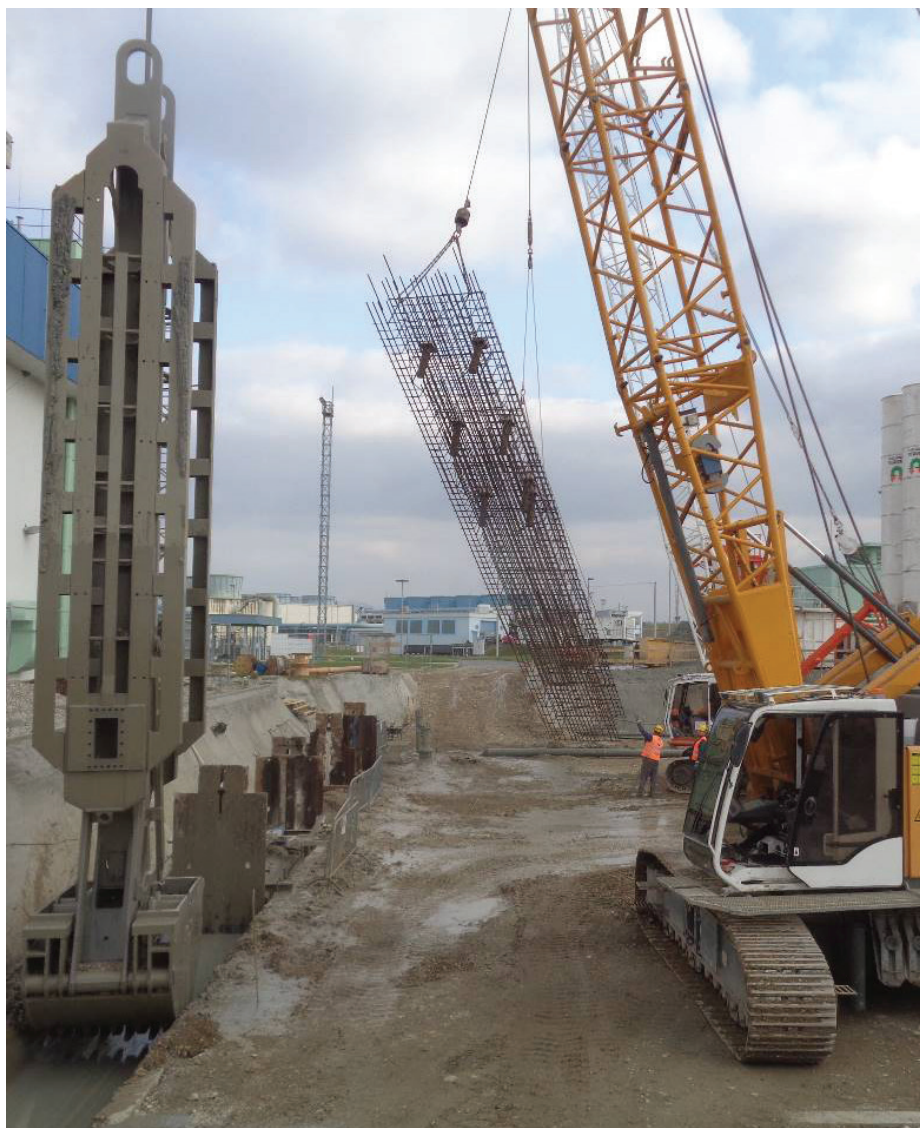
Slika 5 • Izkop za diafragma in vgradnja armaturne koše.
