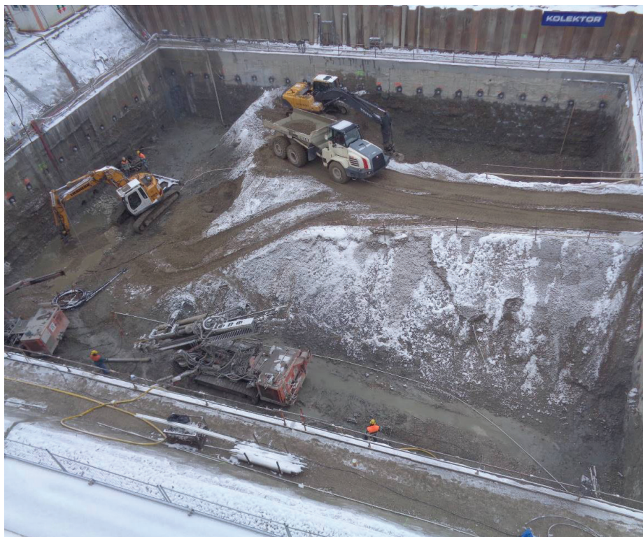
Slika 7 • Izkop in vgradnja sider.
