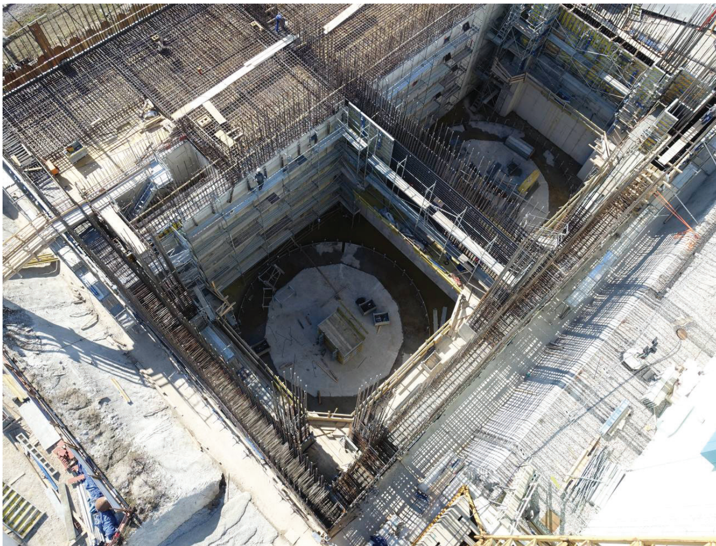
Slika 9 • Gradnja sten etaže P.
