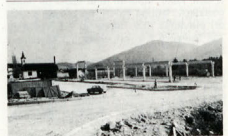
Gradnja proizvodne hale v Mozirju
