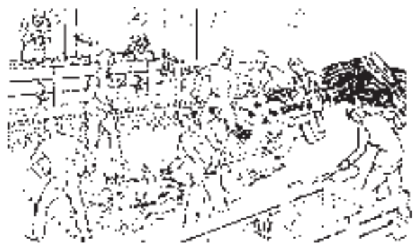
Slika 5: Priprava lahke ilovice na gradbišču in butanje stene: (1) slamo in druge vlaknate dodatke je potrebno razrezati na 10 - 15 cm dolga vlakna, (2) tekočo ilovico se nalije preko vlaknatih snovi, (3) ilovico in vlakna se zmeša z gnojnimi vilami, (4) nalaganje lahke ilovice med opaže, (5) butanje lahke ilovice med opaže, (6) vstavljene letve služijo kot ojačitev stene [Volhard 1995].
