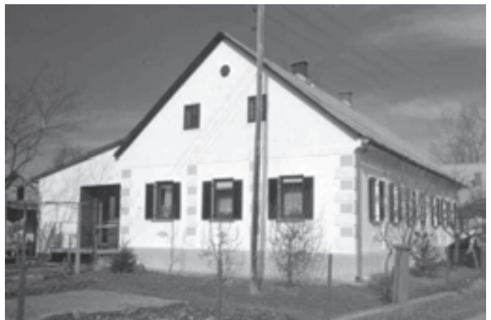
Slika 6: Prenovljena butana hiša iz Placerovcev na Ptujskem polju, grajena 1954. (Foto: M. Zbašnik-Senegačnik) Restored compacted house in Placerovci on Ptujsko Polje, built in 1954.
