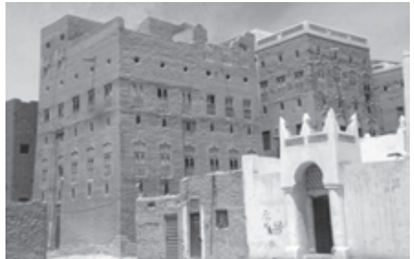
Slika 11: Stene iz ilovnatih zidakov. (Foto: B. Juvanec) Walls made of clay bricks.
