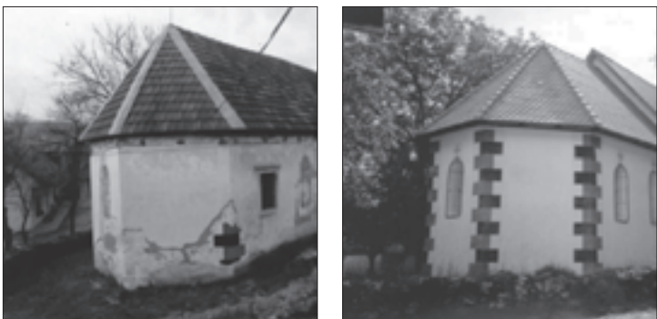
Sliki 7,8: Lopata v Suhi Krajini, p.c. sv. Neže, zunanjščina: spremenjena gotska stavbna lupina in nivo strešne kritine prezbiterja, na severni stranici sta vidna poskusa rekonstrukcije poslikave vogalov (zgoraj); rekonstrukcija stavbne lupine s prvotnimi prezbiterialnimi okenskimi odprtinami, rekonstruiranim ometom, poslikavami vogalov in špalet ter prvotnim nivojem strešne kritine prezbiterja (spodaj). (Foto: Ivan Bogovčič)
