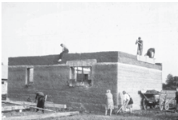
Slika 7: Butanje ilovnatih sten na Ptujskem polju v začetku 70-tih (Foto: D. Moškon) Compacting clay walls on Ptujsko Polje in the early 70s.
