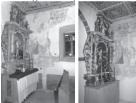
Sliki 5, 6: Lopata v Suhi Krajini, p.c. sv. Neže, notranjščina: stanje pred posegom s preslikanim stranskim baročnim oltarjem, stenski slikami pod beleži in močno okrnjenim lesenim stropom (levo); stanje po rekonstrukciji oltarja, stenskih poslikav, stropa in oltarne menze (desno). (Foto: Ivan Bogovčič)
