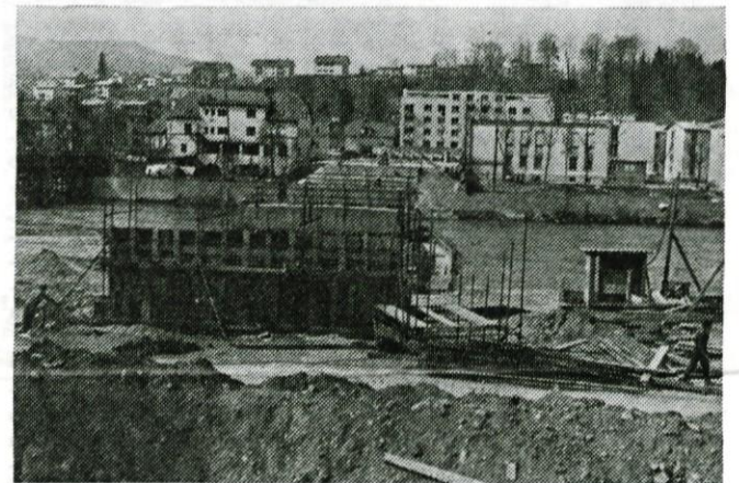
Gradnja mostu lepo napreduje. Foto: T. Štrus
