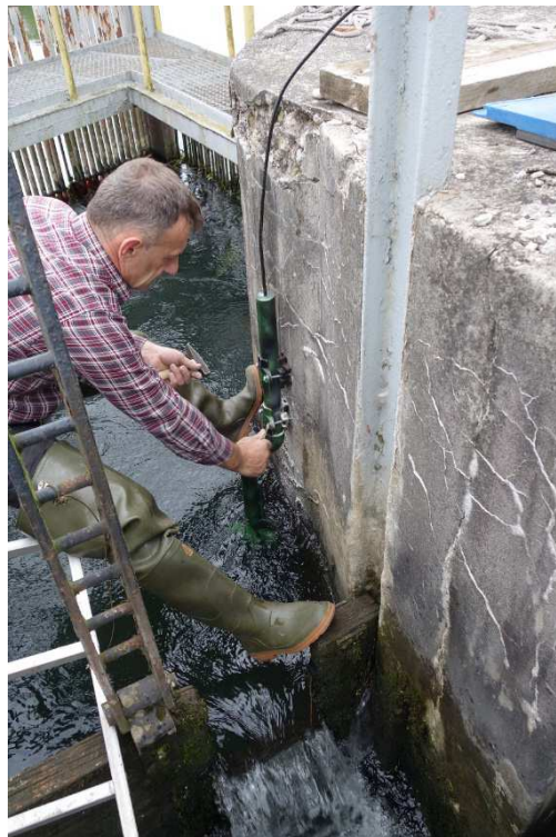
Slika 3: Montaža kontrolne kamere v ribjo stezo na jezu pri Fužinskem gradu
