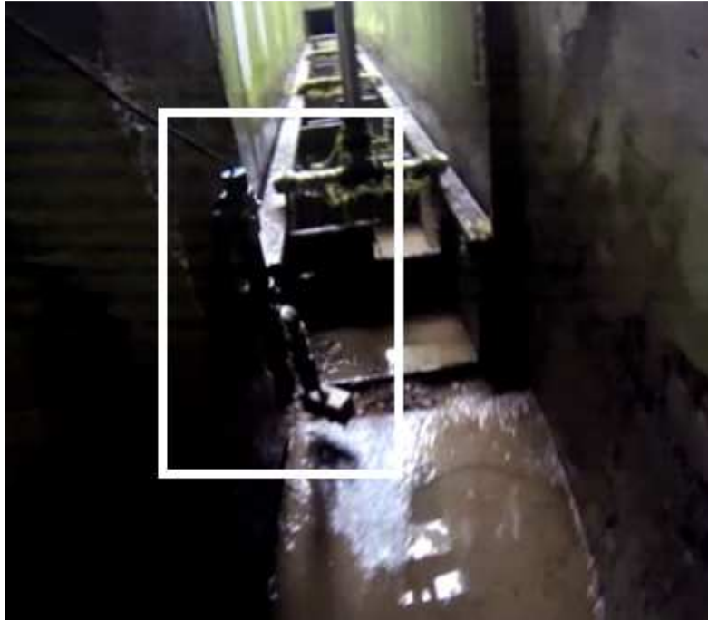
Slika 2. Kontrolna kamera v ribji stezi na Ambroževem trgu (kamera je označena z belim pravokotnikom).
