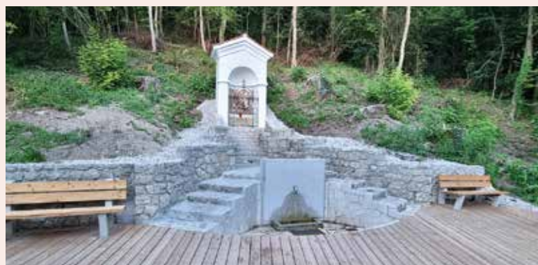
Dočakali smo prvo fazo obnove »žegnanega studenca«.
