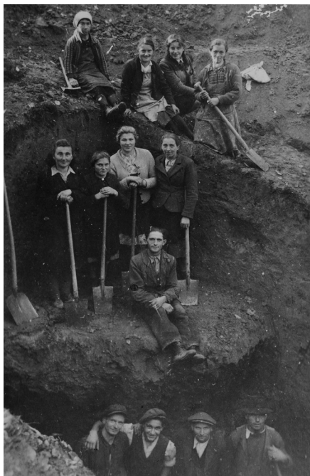
Slika 47: Nemško obrambno linijo so pretežno gradili prisilno mobilizirani krajevni prebivalci. Na sliki kopanje bunkerja na območju Vonarja pri Rogški Slatini.
