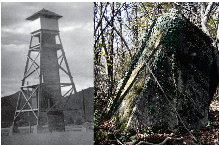
Slika 46: Nemški stražni stolp na meji med Nemčijo in Italijo pri Ljubljani (levo) in ostanek temeljev stražnega stolpa iz Drenovca pri Bukovju na meji med Nemčijo in NDH.
