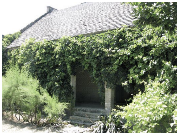
Slika 5 • Dvoriščna fasada hiše v Mošorinu
