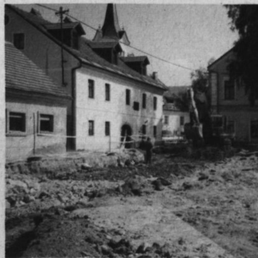
Obnova Kostonjevice na Krki.
