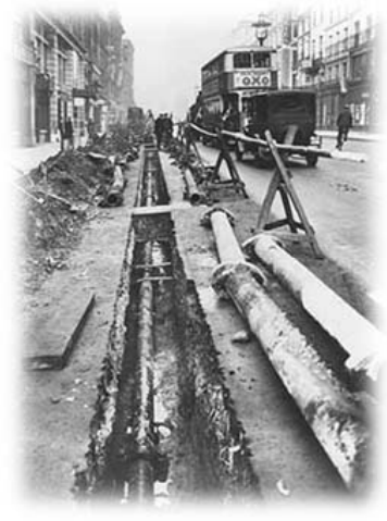
Slika 6 : Načrt visokotlačnega vodnega omrežja v Londonu z glavno postajo in podpostajami iz leta 1895 in polaganje visokotlačnih cevi okoli leta 1930 na Piccadillyju
