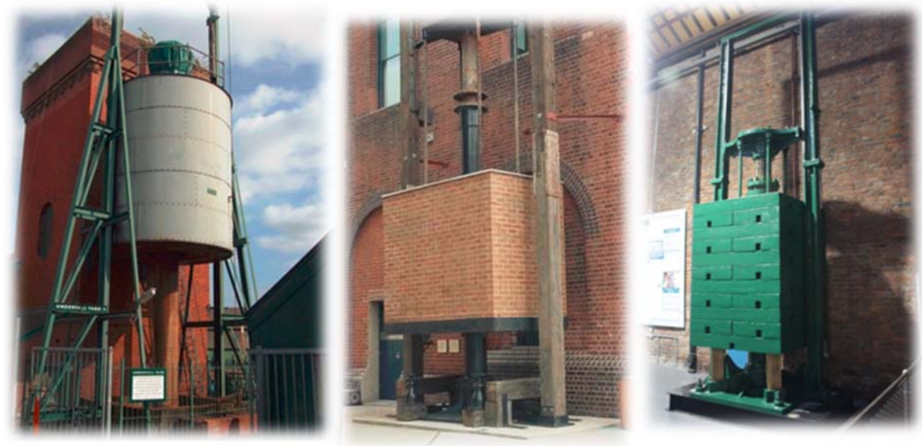
Slika 5 : Hidravlični akumulatorji z utežjo: pristanišče v Bristolu (levo), Walsh Bay v Sydneyju (sredina) in kot izvedba za vgradnjo v notranji prostor (desno) [12]
