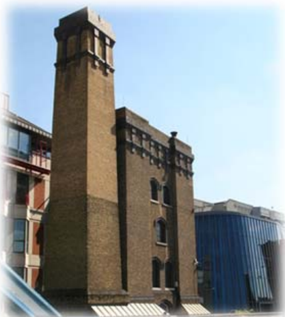
Slika 2 : Vodni rezervoar - akumulator na strehi zgradbe v Hullu (levo zgoraj), dimnik in vodni akumulator za napajanje dvignega mostu Tower Bridge (levo spodaj) in Grimsby Dock Tower danes kot ohranjena tehnična zapuščina (desno); [6], [7], [8]
